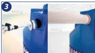
3. Efeetuar as furações para entrada, saída e respiro nas partes planas da Cisterna Bakof destinadas a essa finalidade e realizar as conexões utilizando anéis de vedação.
